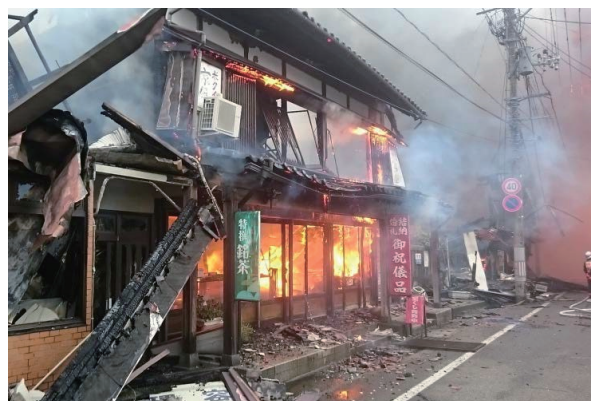
出火場所から約200m離れた場所にも火の手が (糸魚川市消防本部提供)
