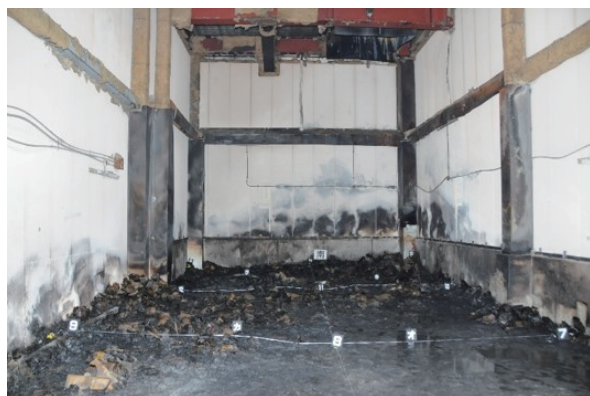
1階端材室内部の状態
