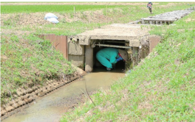
用水路の橋の下に避難する住民
