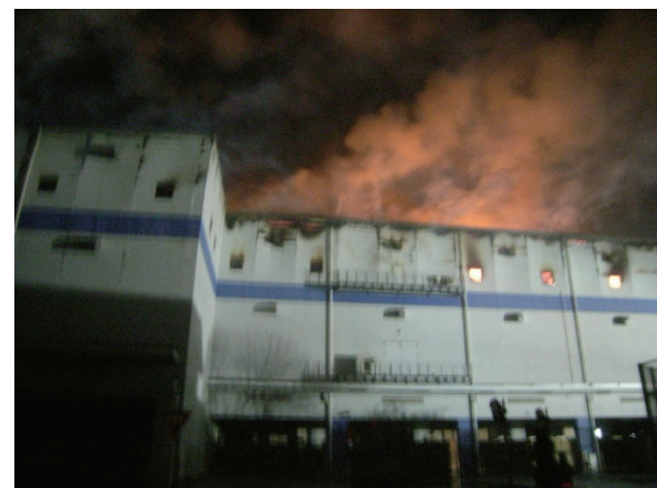
西面延焼状況（19日0時15分頃） （入間東部地区消防組合消防本部提供）
