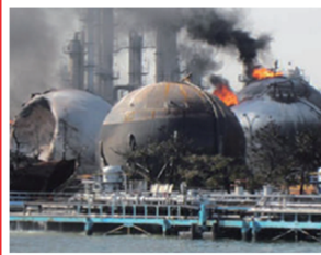
京葉臨海中部地区LPG貯蔵施設 (千葉県市原市)
